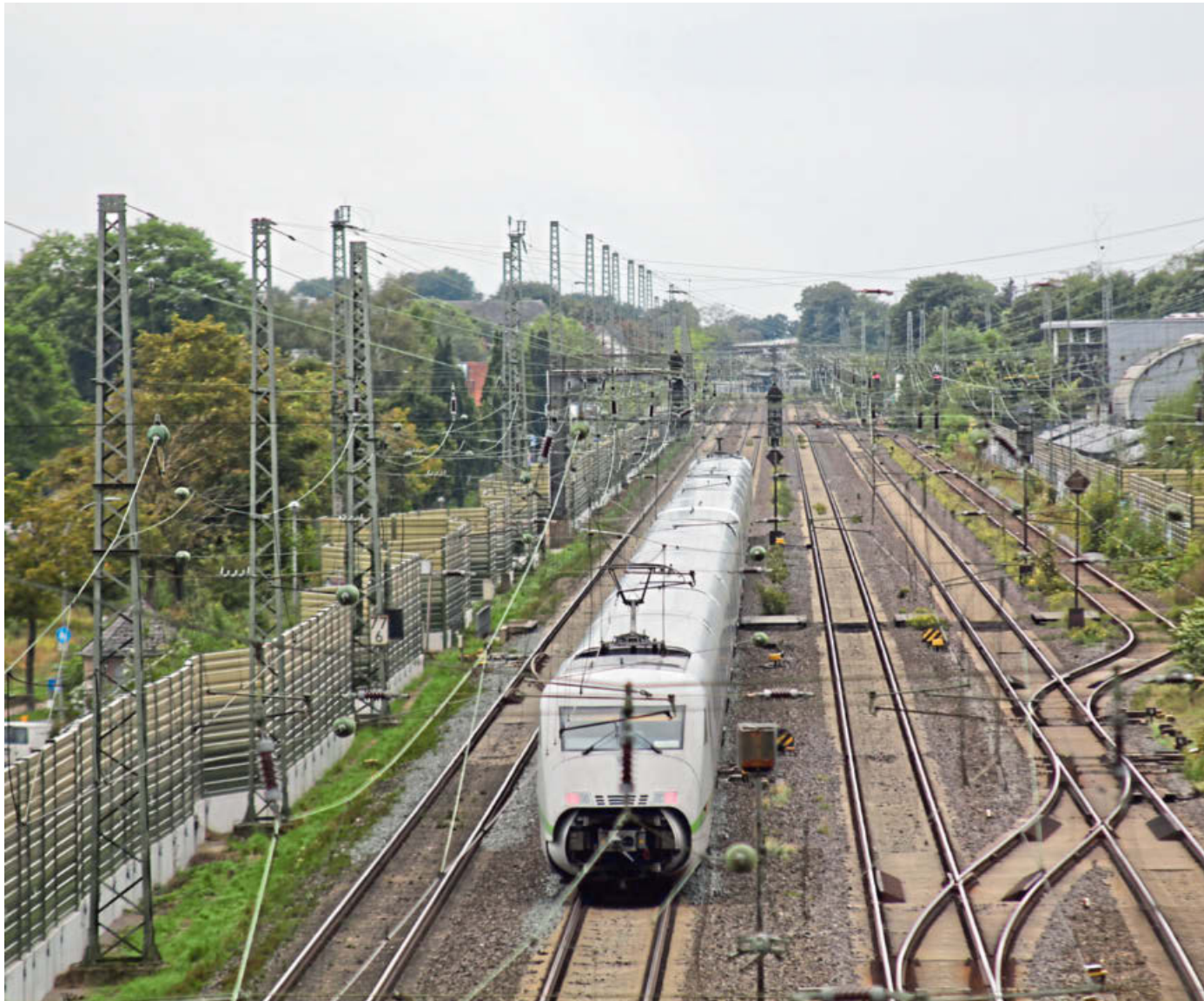
Blick auf die bestehende ICE-Trasse von der Oberbeckener Brücke in Rehme in Richtung Bahnhof Bad Oeynhausen.
